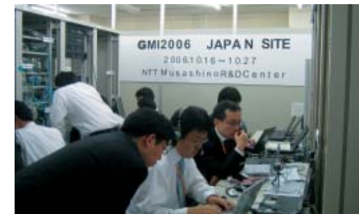
接続試験の様子
